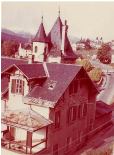
Abb. 66: Die „Villa Felicitas“ während der Abbrucharbeiten 1960/61 (Privatarchiv Schäfer)
