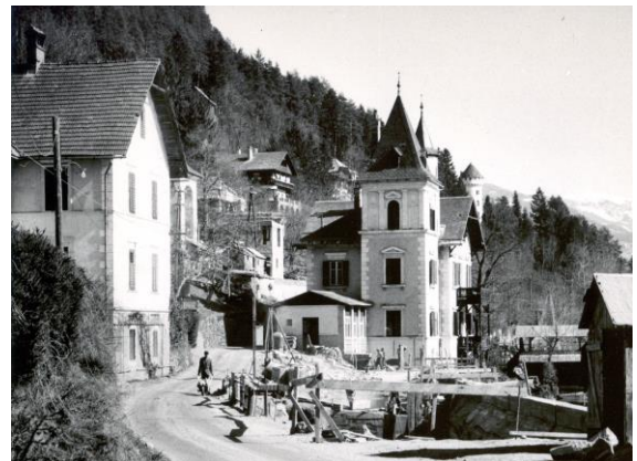
Abb. 26: Bauarbeiten an der alten Bundesstraße B 98 westlich der „Villa Felicitas“ am 21. Februar 1961, Foto: Hans G. Lehnert, Gmünd, Foto-Nr. D 15/1961 (Archiv Dabernig)
