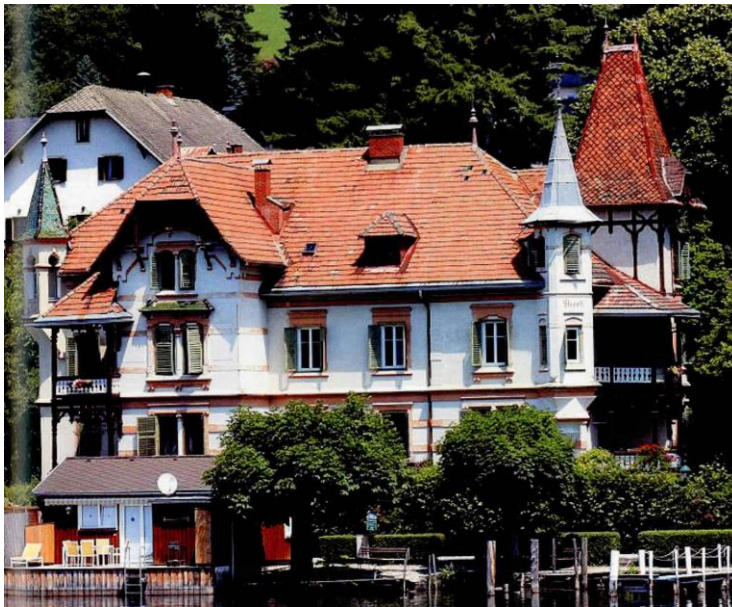
Abb. 39: Villa Streintz, Millstatt, niedriger, eingestellter Rechtecksturm und schmale, aufragende Erker (nach Kühnelt 2012, Abb. 169)
