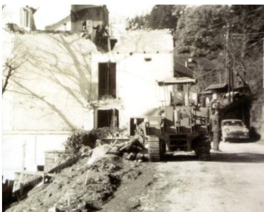
Abb. 69: Die Schubraupe vor dem abgerissenen Anbau an der Ostseite der Villa (Privatarchiv Schäfer)
