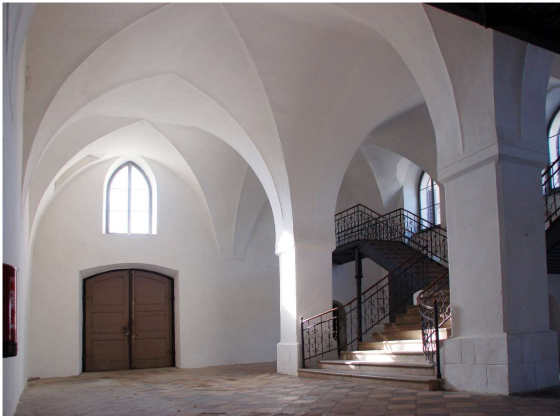
Abb. 41 Blick in die spätgotische Gewölbehalle des Westtraktes (Stiftshof) nach Südwesten. Die zweischiffige Halle wurde innerhalb eines romanischen Speicherbaus errichtet.
