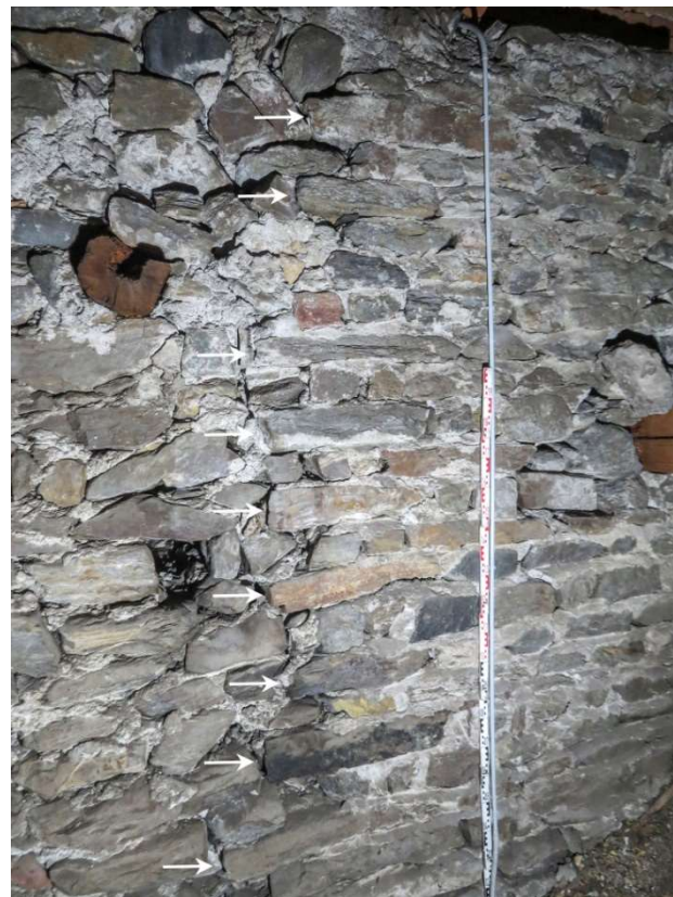
Abb. 8 Mittelschiffmauer über dem südlichen Seitenschiff der Stiftskirche in Höhe des Chorjochs, Ansicht nach Nordosten. Das höher aufragende Handquadermauerwerk des Chorjochs endet nach Westen in einer Zargensteinkette (Zargen mit Pfeilen markiert). Das anschließende Mauerwerk ist Teil des jüngeren Obergadens.
