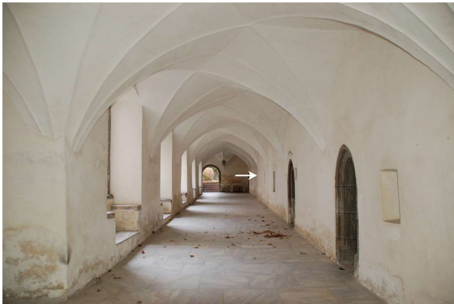
Abb. 17 Südlicher Kreuzgangflügel, Ansicht nach Osten. Die Rückwand des Kreuzgangs bildet am Ostende des Refektoriums einen wahrnehmbaren Fluchtknick (Pfeil).
