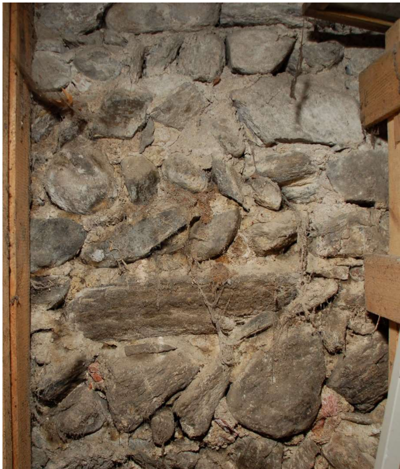
Abb. 12 Mauerwerk des Klostergevierts im Südtrakt, Südwand des Kellers im Südosteck des Gevierts. Lagiges Mauerwerk aus Feld- und Geröllsteinen ohne Fugenverstrich (Pietra-Rasa-Putz).
