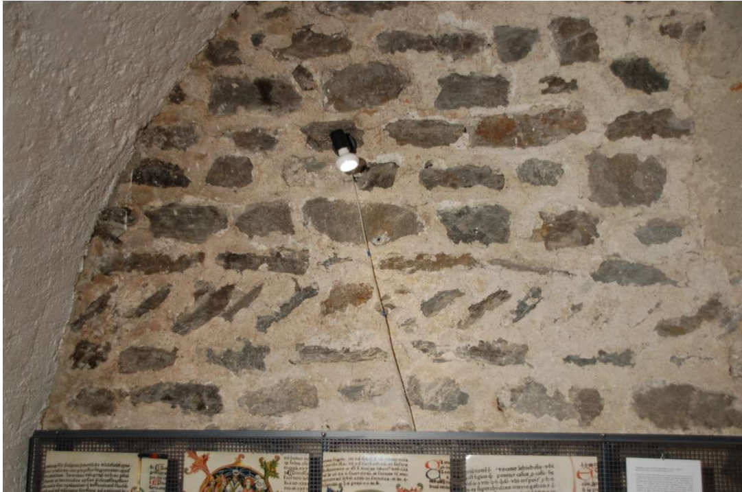
Abb. 11 Mauerwerk des Klostergevierts im Westtrakt, Ostwand des großen Vorratsraums. Lagiges Mauerwerk mit breit verstrichenen Fugen (Pietra-Rasa-Putz) ohne Kellenstriche.
