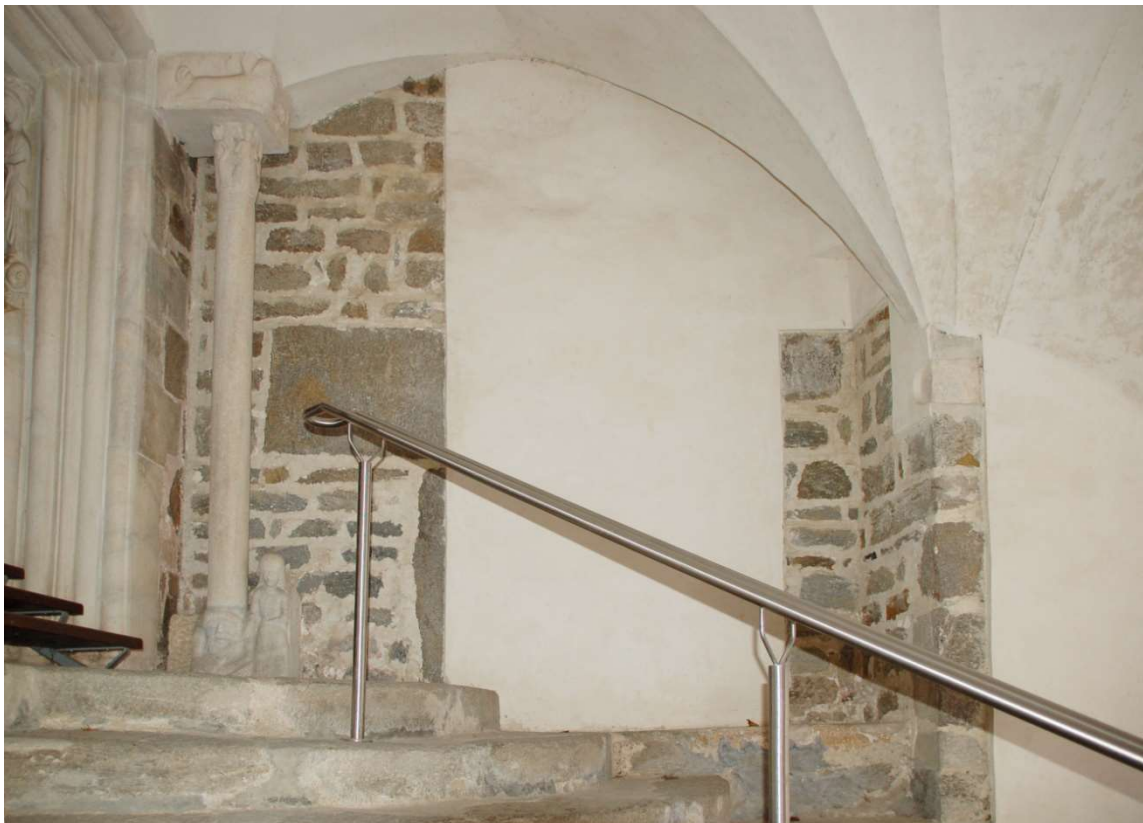
Abb. 19 Rückwand des östlichen Kreuzgangflügels, grenzend an das Südportal der Kirche (links). Die Mauerflucht weicht im letzten Bauabschnitt des Kreuzgang-Osttraktes zurück, um das Südportal der Kirche frei zu halten. Im freiliegenden Mauerwerk sind ein Steher und der Kämpferstein eines Portals zu erkennen, das einst in das Armarium (Bücherdepot) führte.
