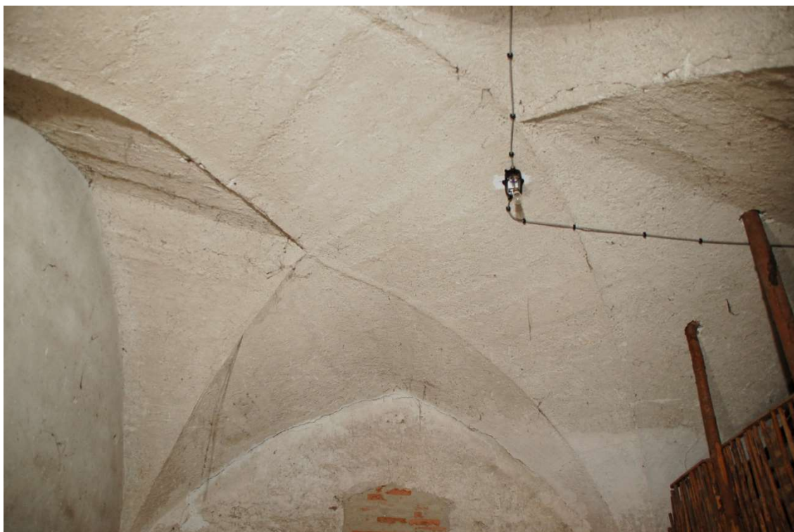
Abb. 35 Westtrakt des Stiftshofs, Joch des zweischiffigen Gewölbekellers in der Nordhälfte des Bautraktes mit angeputzten Graten in Rautenkonfiguration.
