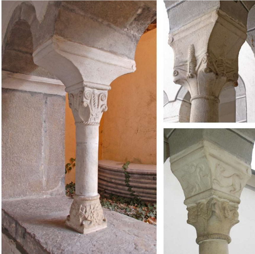
Abb. 13 (links) Kapitelsaalfenster, nördlichste Säulenstellung am Nordpolyforium, Ansicht nach Nordosten. Abb. 14 (rechts) Kreuzgangfenster, zwei Kapitelle mit Kämpfersteinen. Oben: am östlichsten Biforium des Südflügels, unten: am zweiten Biforium von Süd des Ostflügels.
