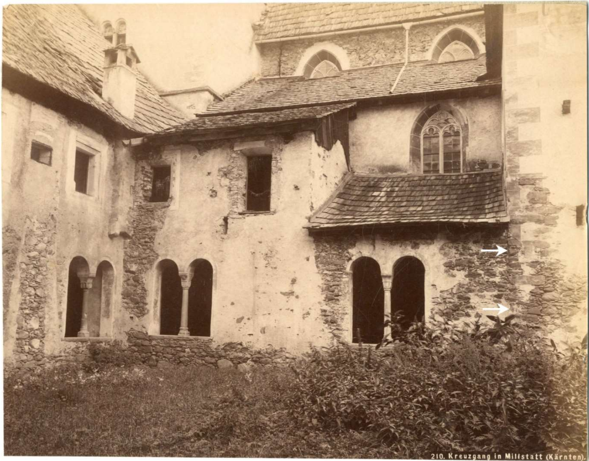
Abb. 44 Stift Millstatt, Kreuzganghof, Ansicht nach Norden. Fotografie von Otto Schmidt, Wien, ca. 1887. Die Kreuzgangmauern bestehen aus spätgotischem Zwickelmauerwerk. Die Nordmauer steht an der mit Ecksteinen besetzten südwestlichen Gebäudeecke der spätgotischen Seitenschiffkapelle an (rechts im Bild). Beim Neubau des Kreuzgangs um 1500 war im Bauablauf zuerst die Seitenkapelle errichtet worden. An der Nordseite des Kreuzgangs bestand anstelle eines durchlaufenden Obergeschoßes ein vorkragender hölzerner Laufgang. Darauf verweisen Balkenlöcher an den Fassaden der Kapelle und des Obergeschoßes über dem nördlichen Kreuzgangflügel (vgl. Abb. 47).
