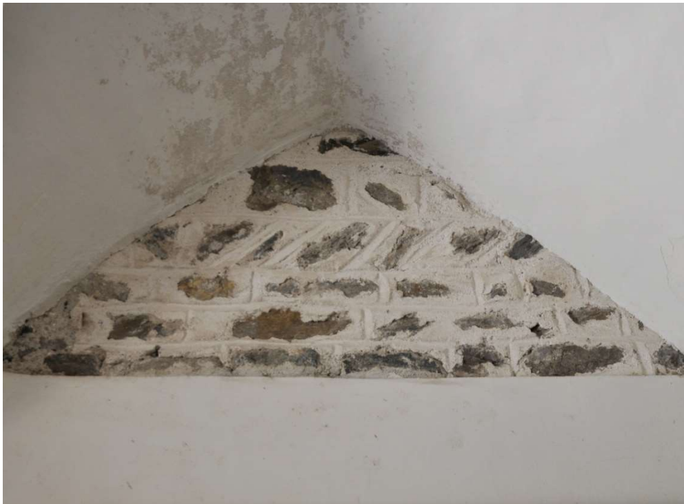
Abb. 10 Mauerwerk des Klostergevierts im Westtrakt, Nordwand des Erschließungsraums (angrenzend an den großen Vorratsraum). Lagiges Mauerwerk aus Feldsteinen mit Schrägversatz. Das unregelmäßige Steinmaterial wird von einem flächig angetragenen Pietra-Rasa-Putz mit quaderhaft eingezogenem Fugennetz bedeckt.
