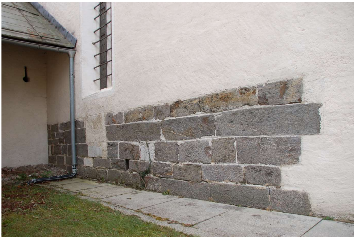
Abb. 3 Romanisches Großquadermauerwerk der nördlichen Seitenschiffmauer der Stiftskirche.
