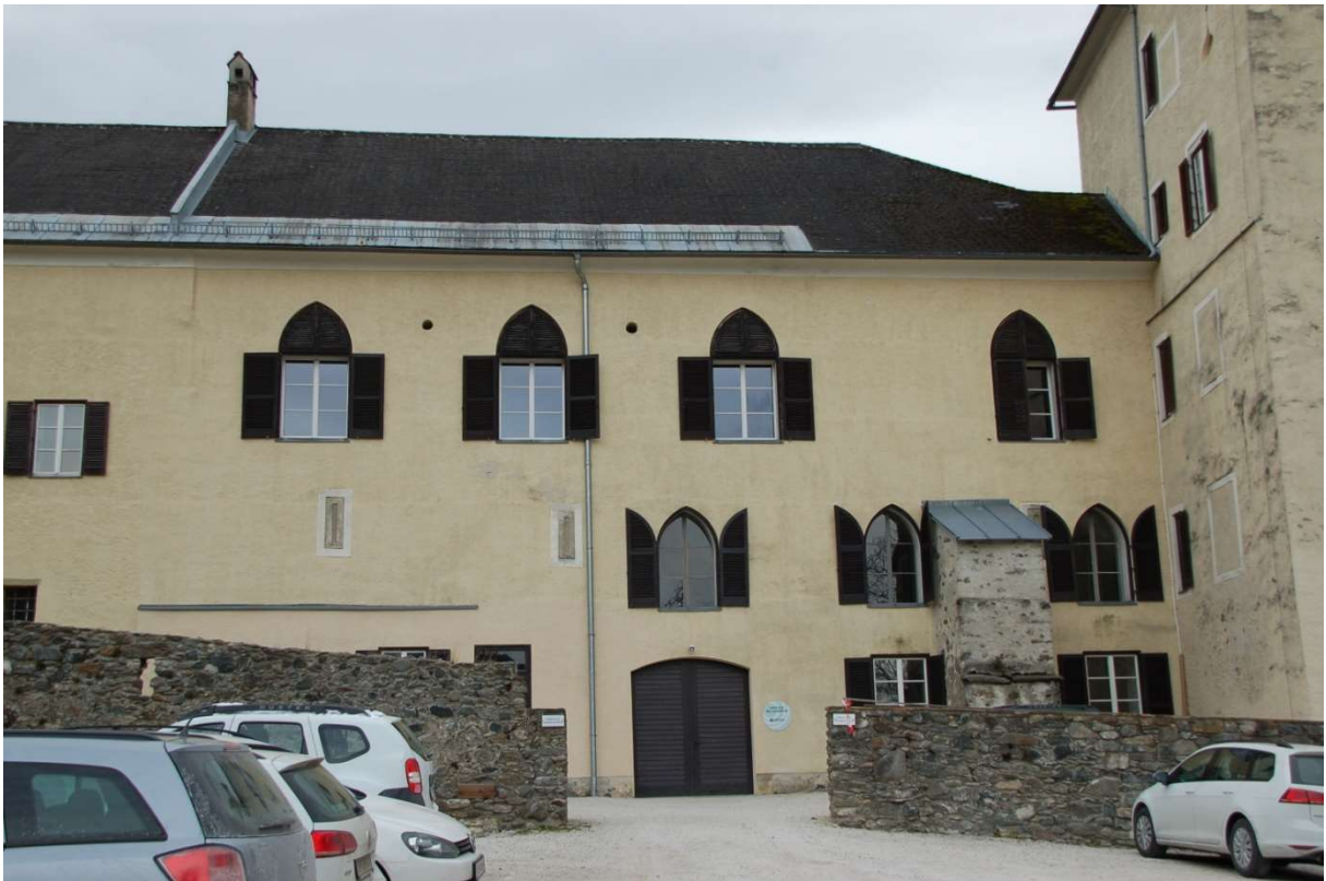
Abb. 26 Ehem. romanischer Kornspeicher, integriert in den Westtrakt des Stiftshofs. Das zweigeschoßige Gebäude wurde in der Spätgotik aufgestockt.
