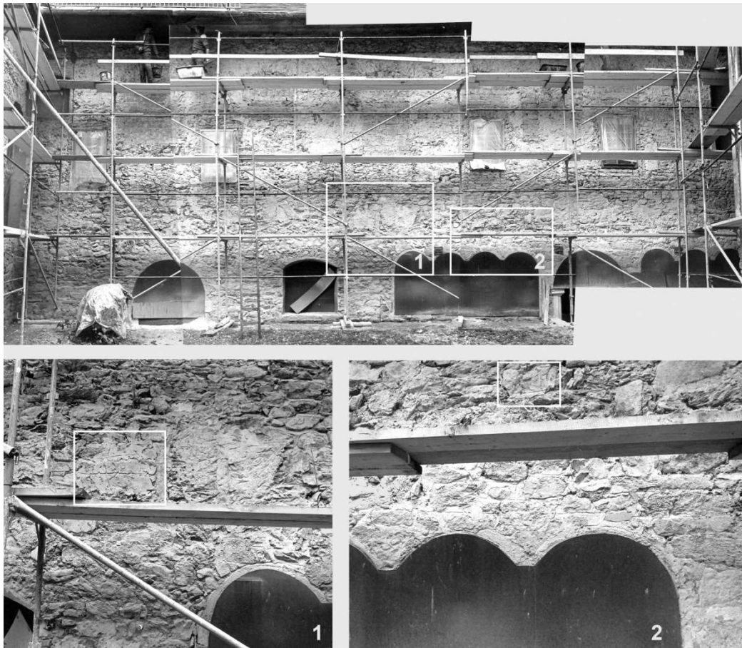
Abb. 20 Westmauer des abgebrochenen Kreuzgang-Osttraktes während der Restaurierung 1983. Sämtliche Verputze wurden damals abgeschlagen. Fotocollage und Ausschnitte aus Aufnahmen des BDA (Ulrich Harb). An der Wandfläche des ehem. Obergeschoßes blieben Reste des deckend angetragenen romanischen Pietra-Rasa-Putzes mit Fugennetz haften. (BDA, Abtlg. für Kärnten, Bildarchiv)
