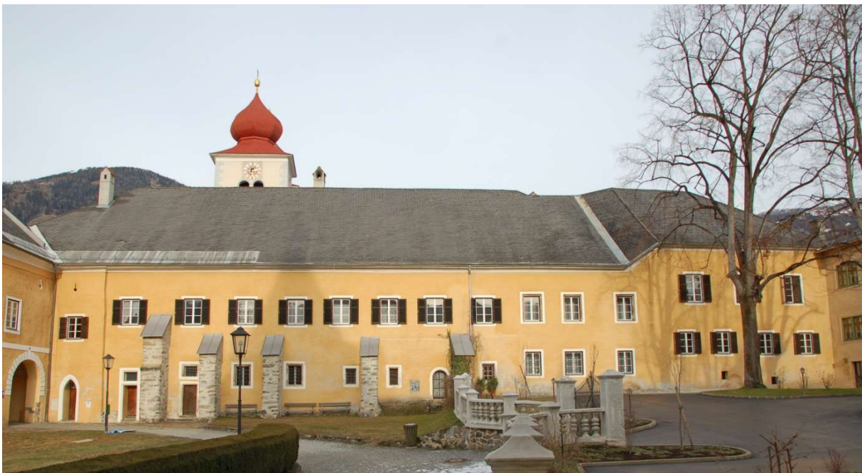
Abb. 21 Südtrakt des Klostersgevierts, Ansicht der Südfassade. In der Breite der vier östlichen Achsen (rechts) ragte einst der Osttrakt über den Südtrakt hinaus.
