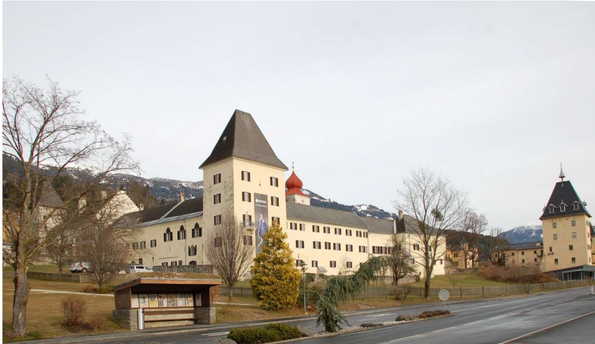
Abb. 1 Ansicht der ehem. Stiftsgebäude nach Nordosten. Im Vordergrund der West- und Südtrakt des Stiftshofes, im Hintergrund der Lindenhof.
