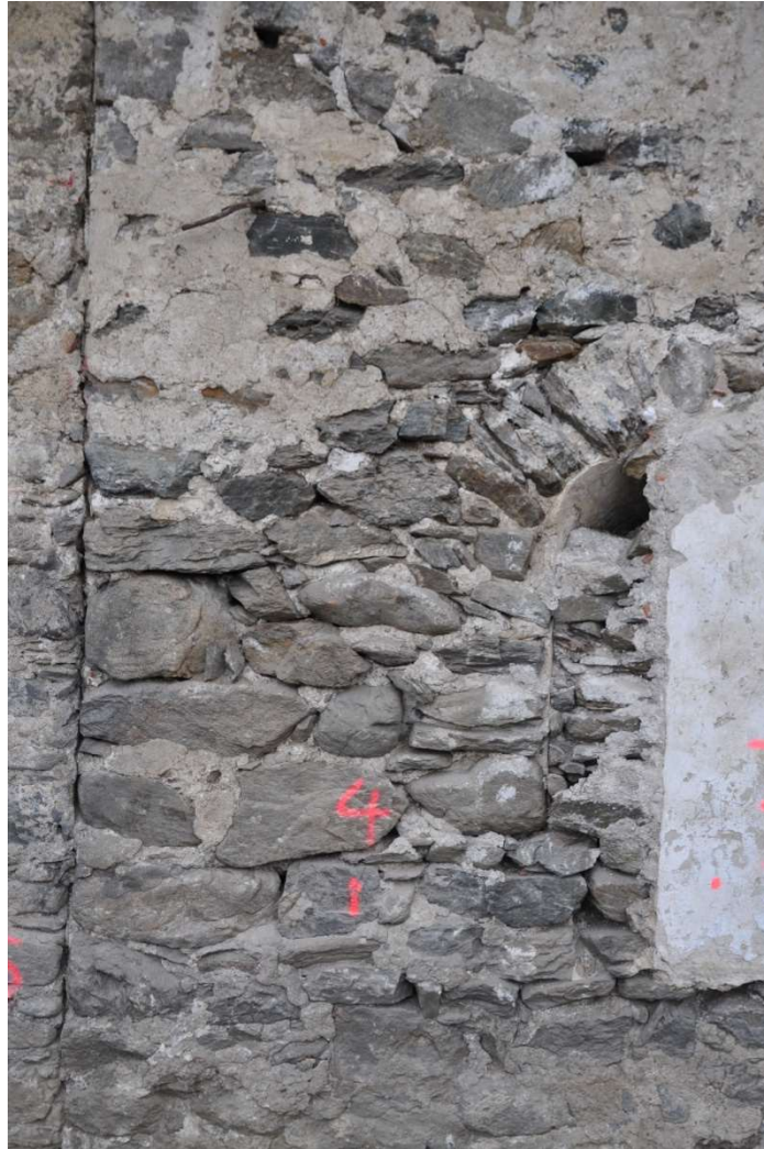
Abb. 30 Getrichtertes Rundbogenfenster in der Ostmauer des ehem. Klostergebüudes (Krankenstation).
