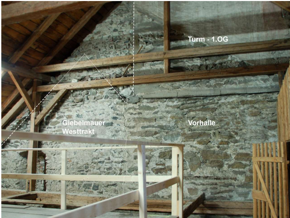
Abb. 9 Dachraum über dem Westtrakt des Klostergevierts, Ansicht nach Norden. Die Südmauer der Kirchen-Vorhalle mit sich darüber erhebendem Turm bricht in die ältere Giebelmauer des Westtraktes ein.
