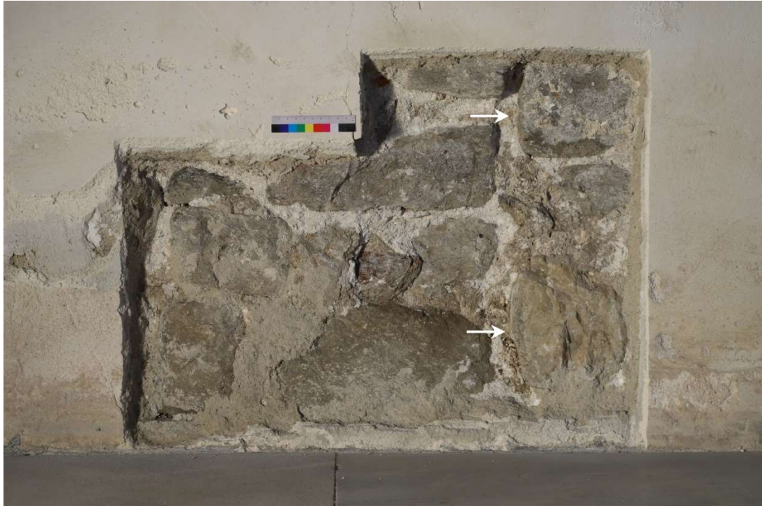
Abb. 18 Gemauerte Nordost-Ecke des Refektoriums innerhalb des Kreuzgangs (vgl. Abb. 17). Die Eckausbildung markiert einen eigenen Bauabschnitt (vgl. Abb. 15).
