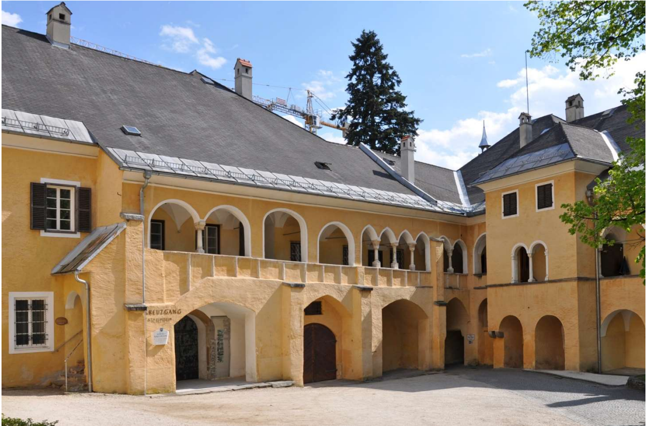
Abb. 36 Arkadengang im Stiftshof. Der Gang wurde der Fassade des Kreuzgang-Westtraktes zur Erschließung dessen Obergeschoßes vorgelegt.
