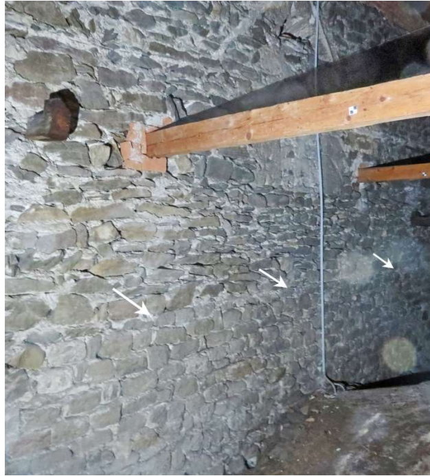
Abb. 7 Mittelschiffmauer über dem nördlichen Seitenschiff der Stiftskirche, Ansicht nach Südwesten. Eine horizontale Baufuge markiert den Wechsel vom Handquadermauerwerk zum jüngeren Schichtmauerwerk des Obergadens mit vermauertem Rundbogenfenster.
