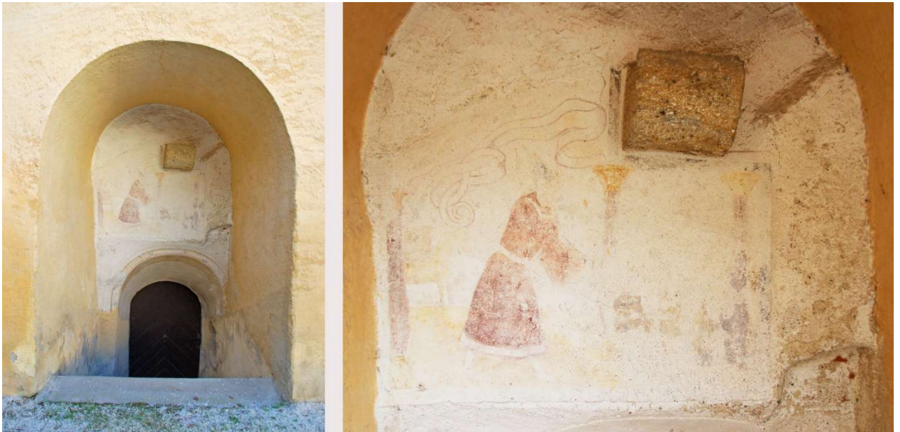
Abb. 37 Kellerabgang in den Westkeller des Südtraktes im Stiftshof. Die Wandmalerei nimmt auf einen älteren Stiegenaufgang Bezug, der das Obergeschoß des spätgotischen Bautraktes erschloss.
