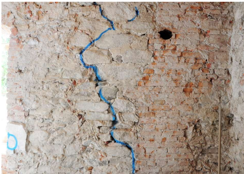
Abb. 23 Westwand im Obergeschoß des sog. Klosterstöckls, ehemals Ostfassade des Klostergevierts. Das romanische Mauerwerk reißt nach Süden hin ab (links). Nach Norden hin besteht eine Störung durch einen Kamin. Die fehlende Gebäudeecke belegt den einst über den Südtrakt vorkragenden Flügel des Osttraktes,
