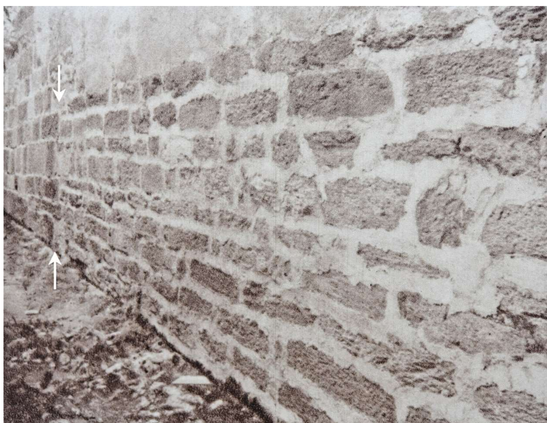
Abb. 4 Nördliche Seitenschiffmauer mit freiliegendem Quadermauerwerk, Abb. aus Ginhart, Kärntner Seestifte 1955. Im Bildhintergrund das heute noch freiliegende Großquadermauerwerk des ersten Bauabschnitts bzw. -phase. Die Pfeile markieren den Mauerwerkswechsel des zweiten Bauabschnitts.
