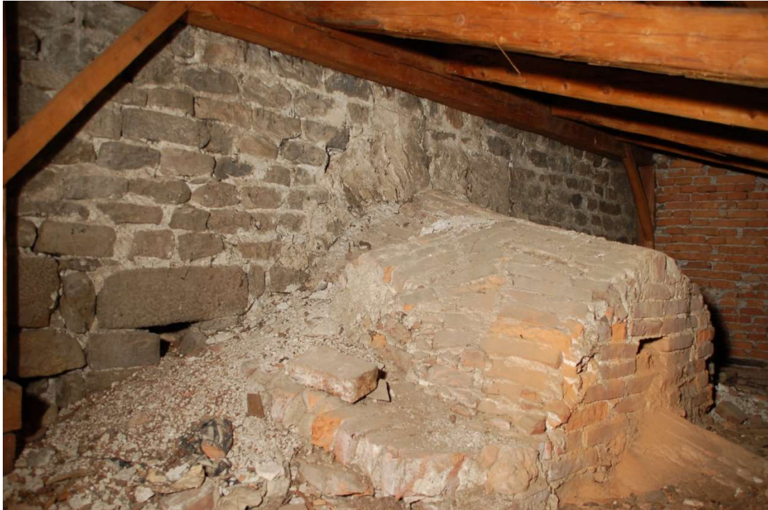
Abb. 5 Handquadermauerwerk an der Außenseite der südlichen Seitenschiffmauer der Stiftskirche, sichtbar im Dachraum über dem Obergeschoß des nördlichen Kreuzgangs. An die Seitenschiffwand schließt das Gewölbejoch eines ehem. spätgotischen Zugangs zur Westempore an.
