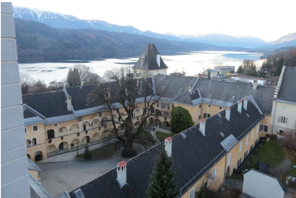
Abb. 31 Blick vom Kirchturm auf den Stiftshof nach Südwesten.
