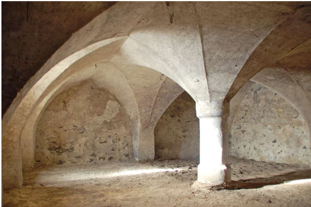
Abb. 28 Westlicher Keller des gotischen Bautraktes südwestlich des Klostergevierts. Ansicht nach Nordwesten. Ursprünglich flach gedeckt, in der Spätgotik eingewölbt (um 1500).
