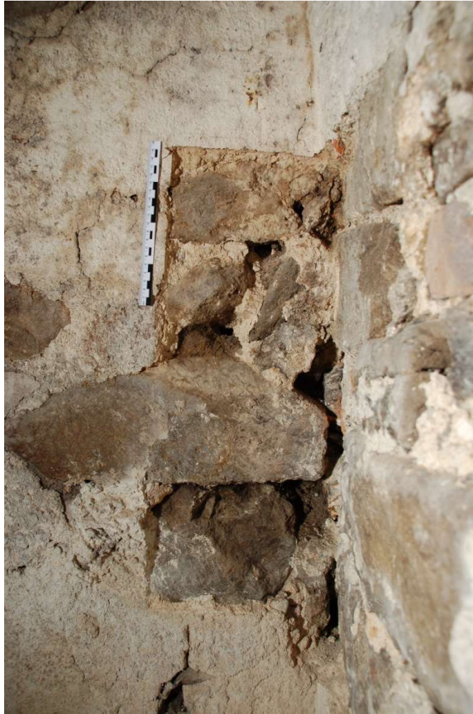
Abb. 16 Sondierung im Nordwesteck des ehem. Refektoriums. Die Westmauer steht an die Nordmauer (rechts) an (zugleich Rückwand des Kreuzgangs).
