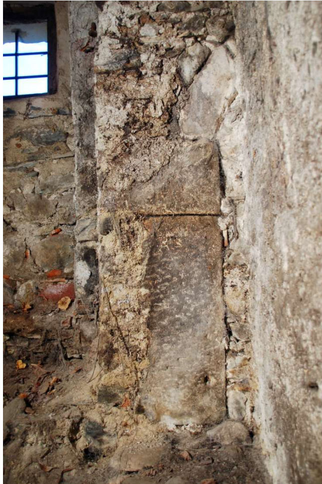
Abb. 22 Gewändesteine eines romanischen Rundbogenportals in der Südmauer des Kellers im Südosteck des Klostergevierts. Das Portal führte in den abgebrochenen Flügel des Osttraktes.
