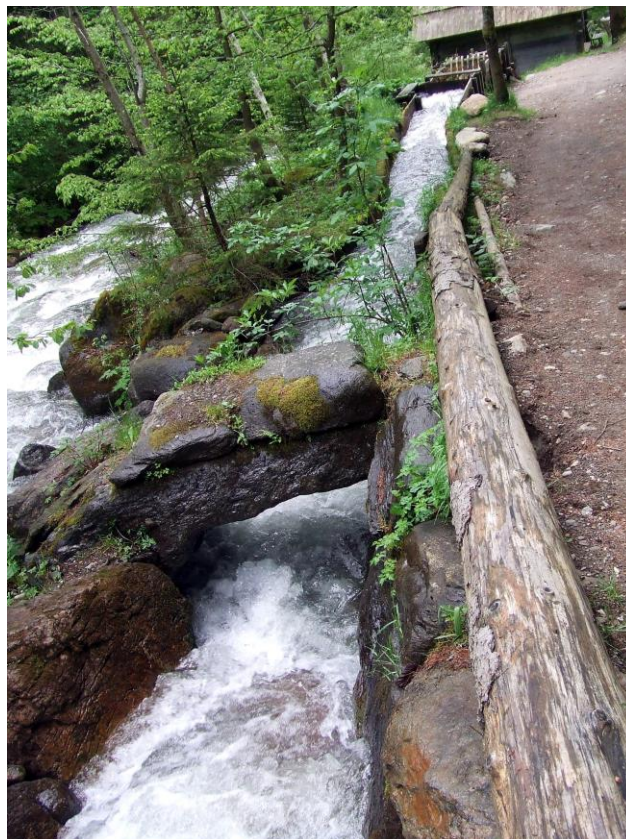
Abb. 33 Kaning, Mühlgang mit steinerner Streichwehr. (Foto: Axel Huber, 2008)
