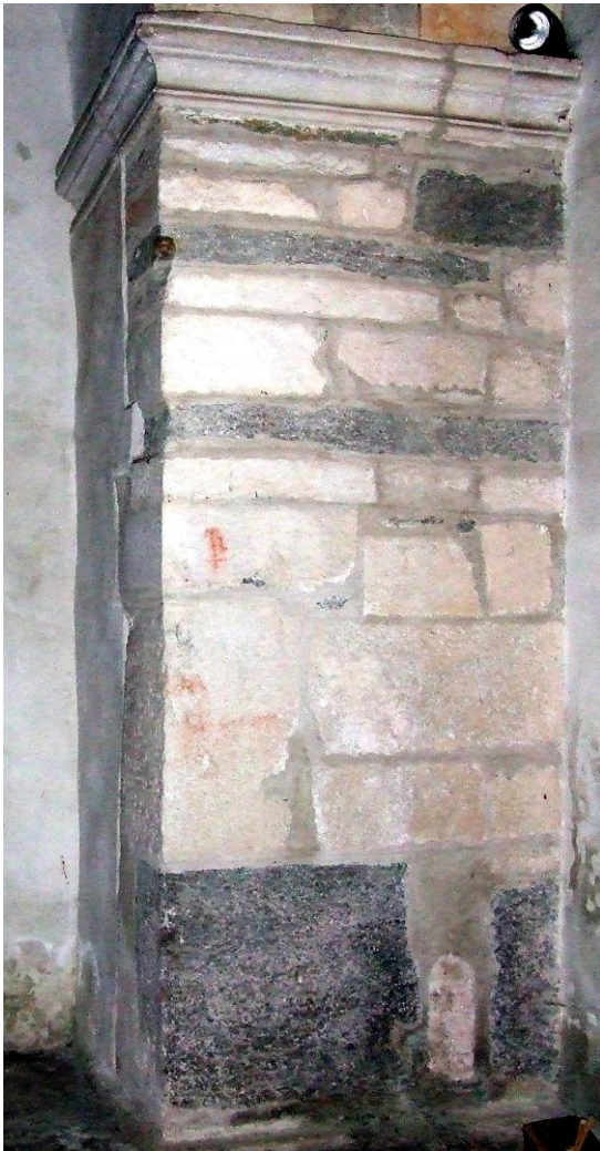
Abb. 36 Millstatt, Mischmauerwerk. (Foto: Axel Huber, 2007)
