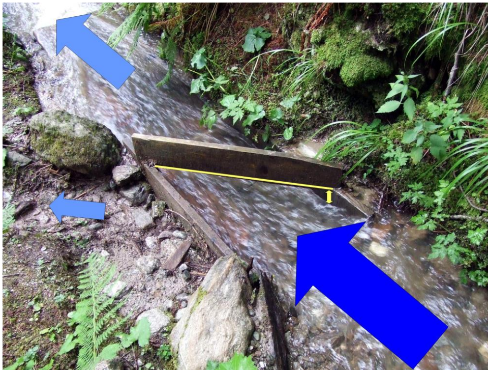
Abb. 30 Obermillstatt, Mühlbach mit hölzerner Streichwehr. (Foto & Grafik: Axel Huber, 2006)
